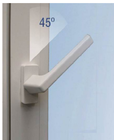
Figura 4.22. Microventilación de serie con apertura estándar y con apertura lógica
