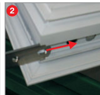
Inserimento del braccio nella canaletta dell'anta
